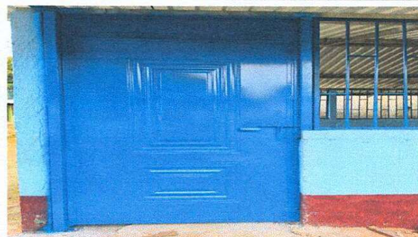
Foto 4: Mejoramiento de la puerta de la cocina
