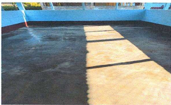
Foto 3: Mejoramiento del piso
