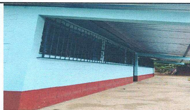
Foto 6: Mejoramiento de balcones
